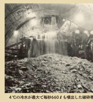
急勾配なため、エレベーターと隧道(トンネル)による輸送を計画。隧道の掘削が進むにつれ温度は不気味に上昇し、高熱地帯に到達。作業員は冷水をかけながら昼夜交代で掘り進めるなど、工事は困難を極めた。さらに、作業員の宿舎を、大雪崩が襲来。四階建ての宿舎が一階を残して吹き飛ばされた。幾多の困難を乗り越え、完成した発電所の出力は当時日本最大を誇った。
